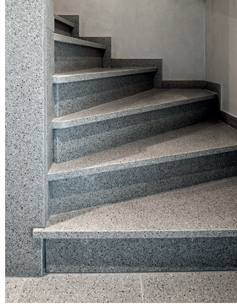
L KESİT PREKAST DÜZ BASAMAK
